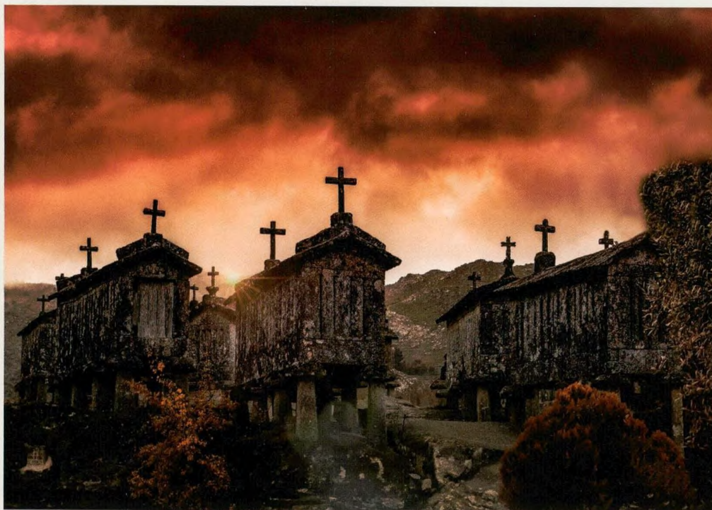
MARCO ALVES Os espigueiros de Soajo, no concelho de Arcos de Valdevez, ainda são usados para secar o milho. Foram construídos em altura para evitar que roedores e outros animais oportunistas pilhassem o sustento da aldeia.
